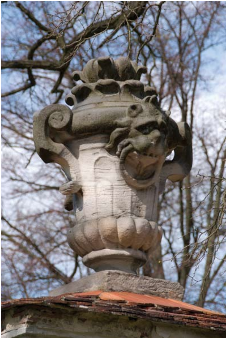
Nietków. Park – zwieńczenie bramy / Park – Torbekrönung Park – gate atop
