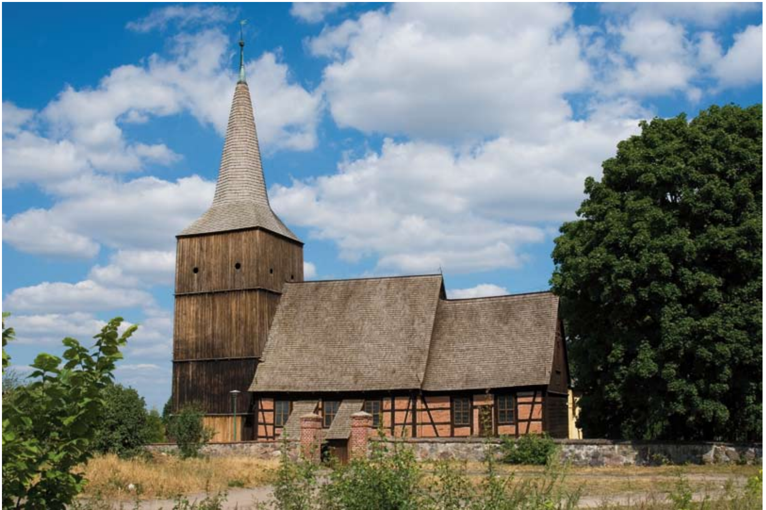
Kłępsk. Kościół z XIV w., przebudowany w XVI w., z wieżą z 1657 r. / Kirche aus dem 14. Jh., im 16. Jh. umgebaut, mit dem Turm von 1657 14th century church rebuilt in the 16th century , the tower built in 1657
