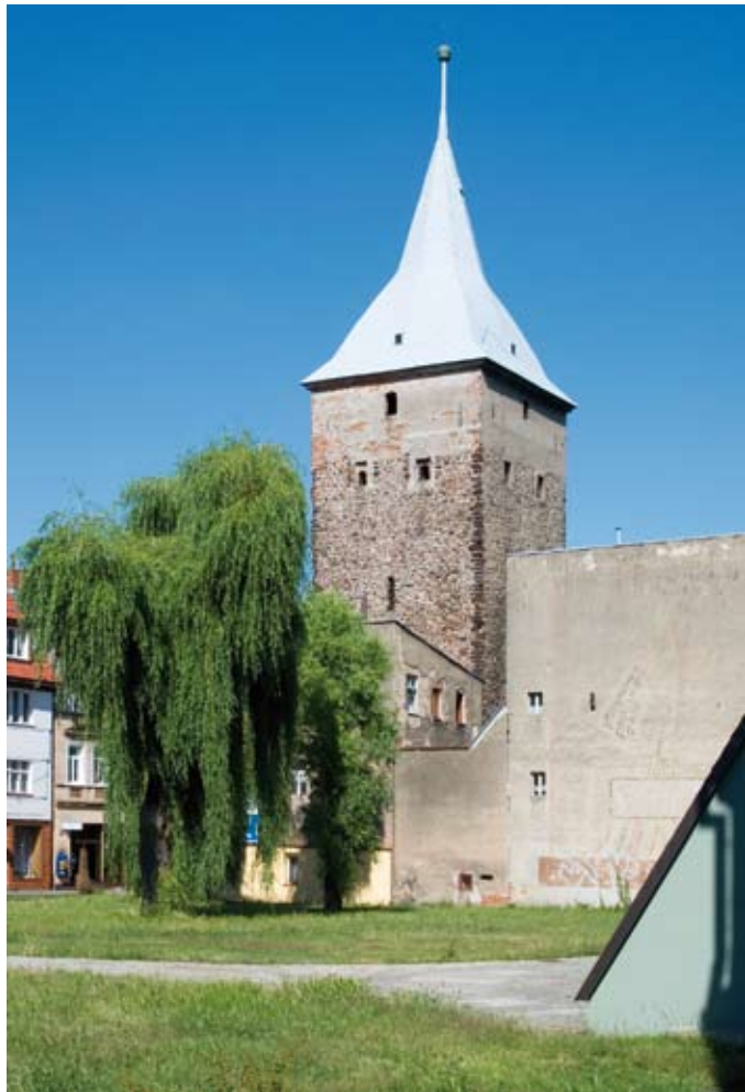
Żary. Wieża Wartownicza, zapewne z końca XIII w. Wachturm, wahrscheinlich aus dem späten 13. Jh. A Guard Tower, probably dating the end of the 13th century
